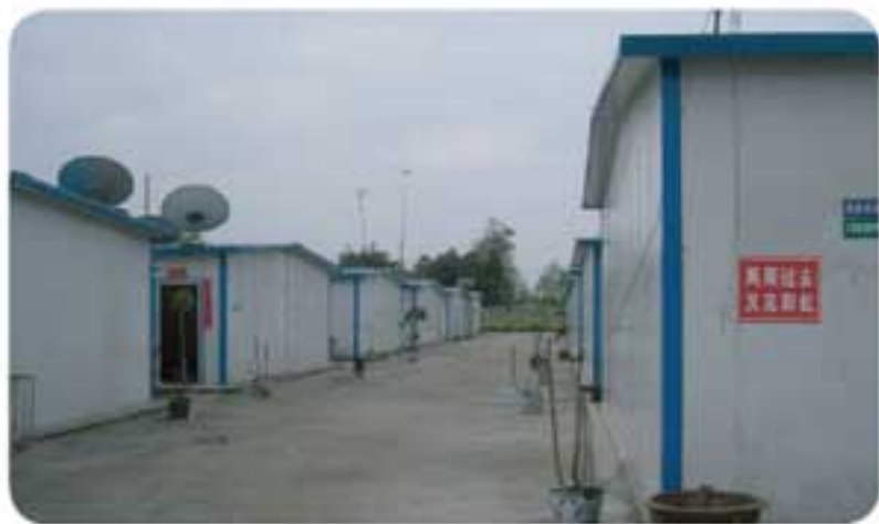
基金动员成都汇厦住房股份有限公司搭建地震灾区的活动板房。
